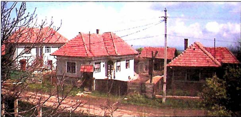
Három azonos stílusban épült, jellegzetes györgyfalvi ház. Az jobb felőli annyira a földre épült, hogy nincs alatta pince. A középső alatt van pince, de néha ellepi a víz. A harmadik annyira magas, hogy alul is laknak.
