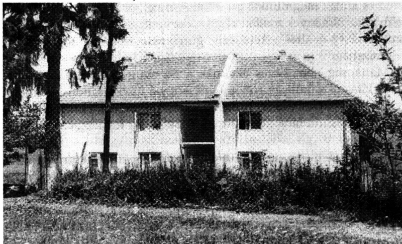
A Nyárádszentlászlói Állami Mezőgazdasági Vállalat dolgozói részére épített tömbházlakás, a vállalattal szemben
