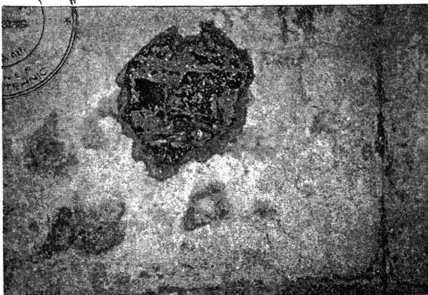
SONDAREA ZIDARIEI DE PIATRA IN SUBSOL LA POZITIA AXELOR 5'/C-D, LATA -1,20m
