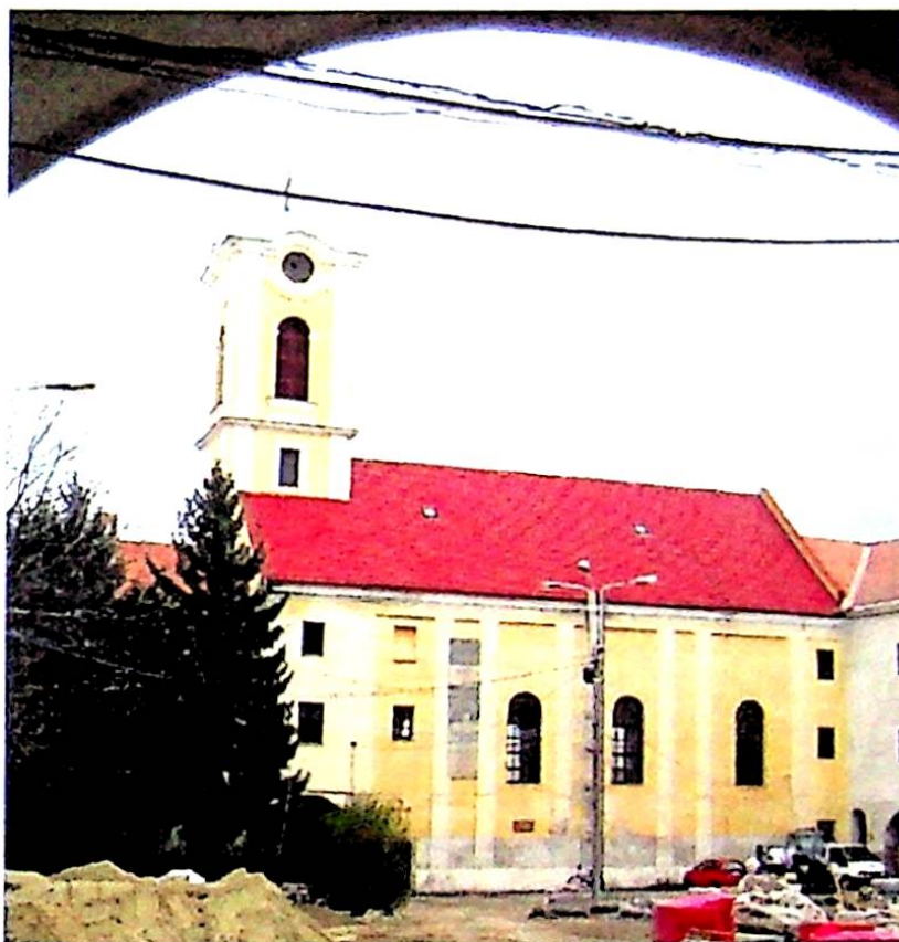
Az 1775-1776-ban épített vártemplom a belső udvar felől
