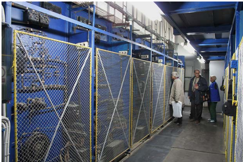
A 0,4 kV-os és 10 kV-os sínrendszerek
