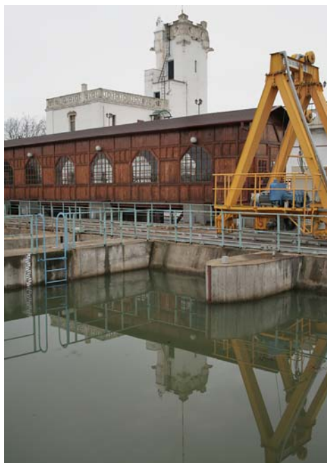
A vízerőmű befolyási oldala
