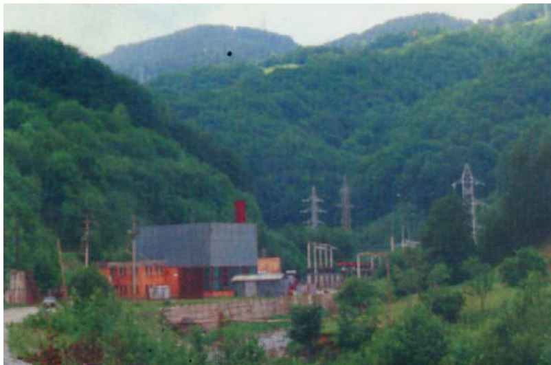
A Munteni vízerőmű
