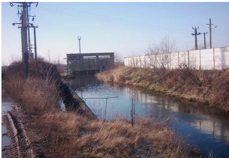
Felvízcsatorna a másik törpe vízerőműhöz
