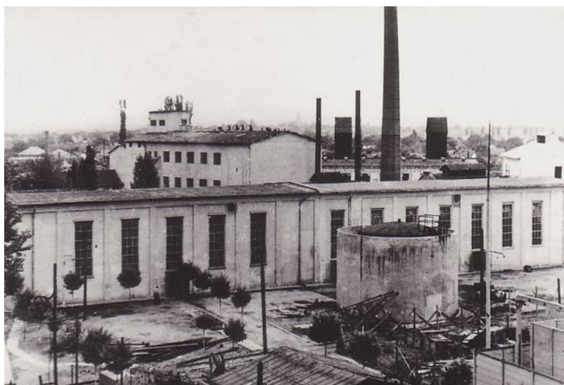
A dízelermű épülete
