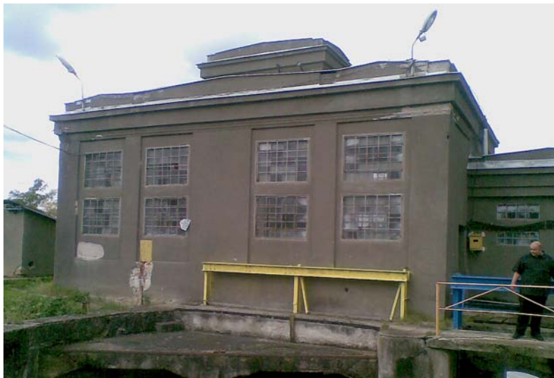
A 2-es erőmű épülete
