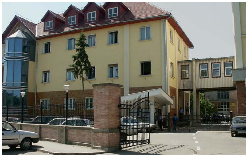
A felújított régi irodaépület és bejárat napjainkban a Sánc (Griviței) utcán
