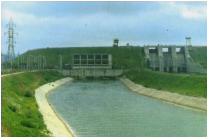
A mezőtelegdi vízerőmű
