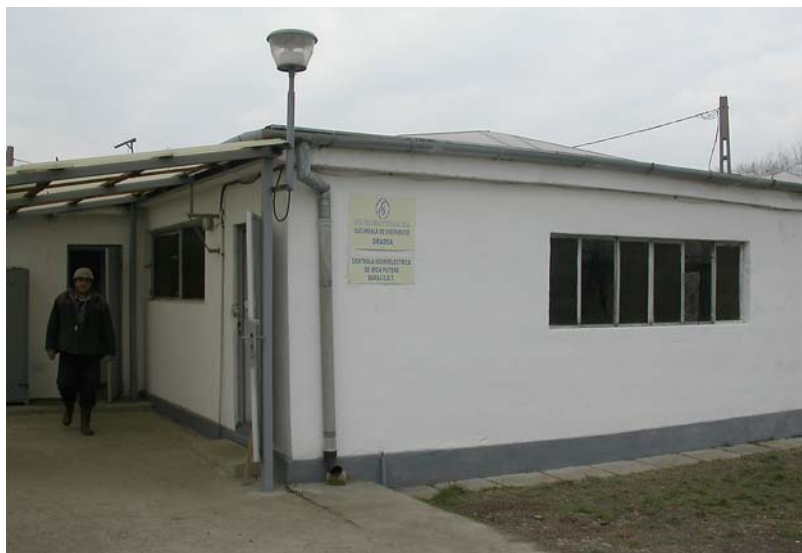
A nagyváradai Gát törpe vízerőmű épülete
