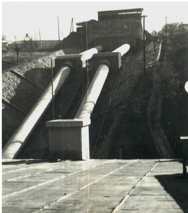
Az erőműbe beömlő vízcső vezetékéi
