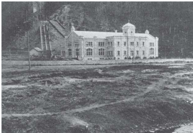
A resicabányai erőtelep, háttérben a nyomócsővezetékkel
