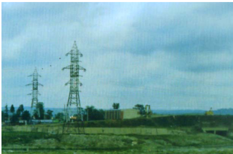
A szakadati vízerőmű
