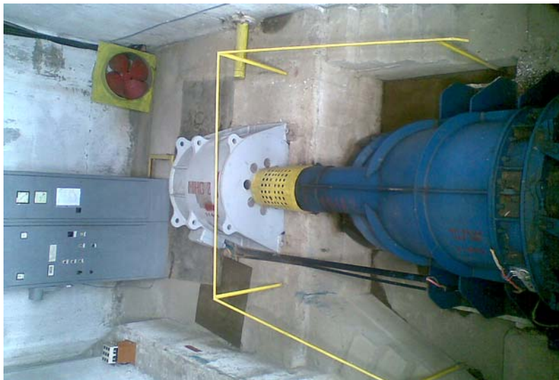
A jelenleg működő EOS-turbina és generátor
