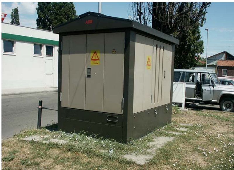
Előregyártott transzformátorház
