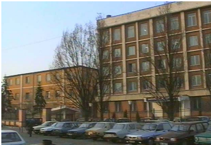
Modern, új és modernizált régi épület a Villanytelep mai bejáratánál
