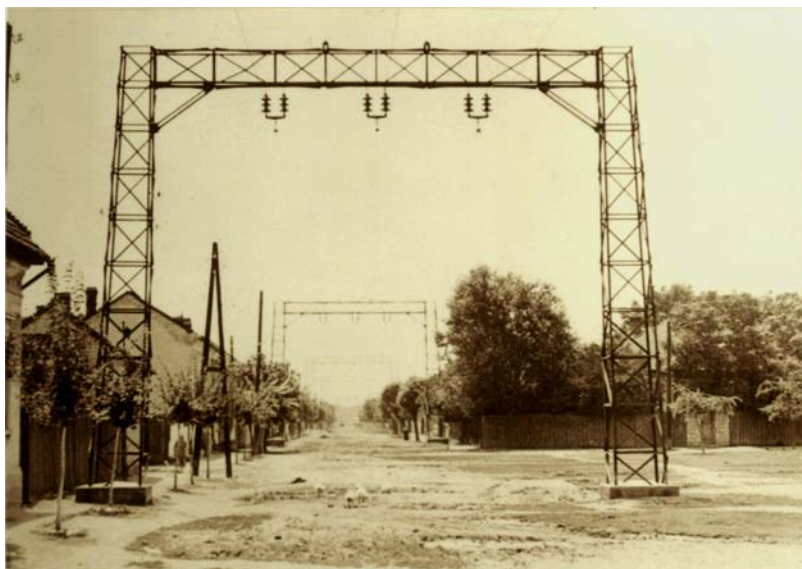
A Nagyvárad-Esküllő 35 kV-os távvezeték portál oszlopa
