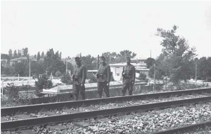
Járőrben a nagyváradi vasúti híd mentén, a régi strand mellett (balról az első)
