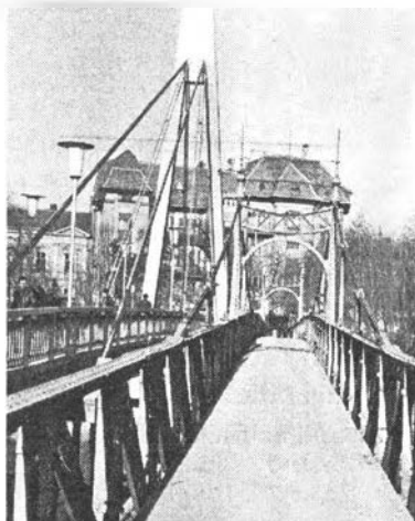
Épül az új híd a Garasos híd mellett
