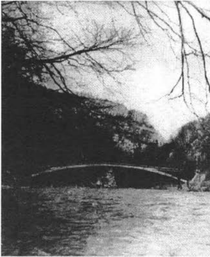
Az új híd a barlangi megállónál
