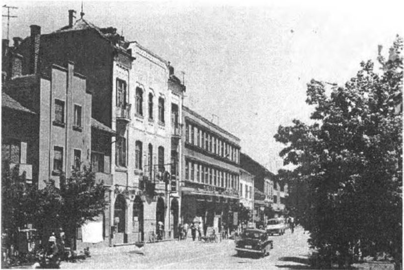
A főtérr napos oldalán a volt Központi Szálló
