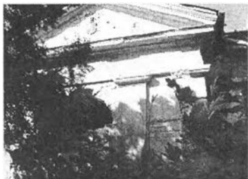
65. A Haller kápolna egyik mellékhomlokzata a Kelemen család címérével
