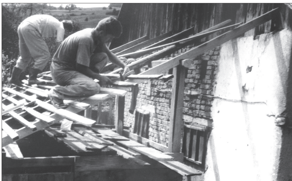
1. kép. Disznópajta építése félfedéllel (1999)
