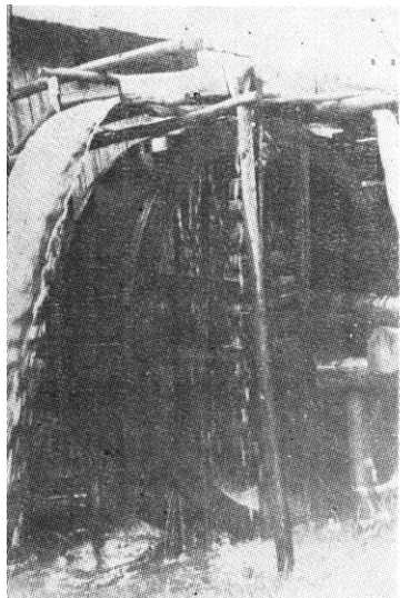
32. A fűrész vízkereke és bélkereke. 33. A fűrész szerkezete. Mál Mál
