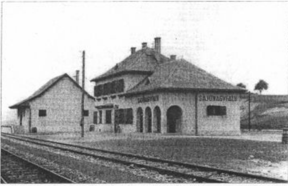
56. ábra. Sajónagyfalu állomás felvételi épülete
