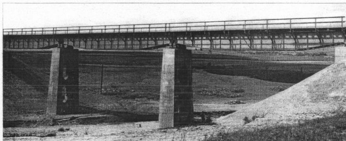
27. ábra. A 423/4 szelvényben lévő nagyvölgyi híd
