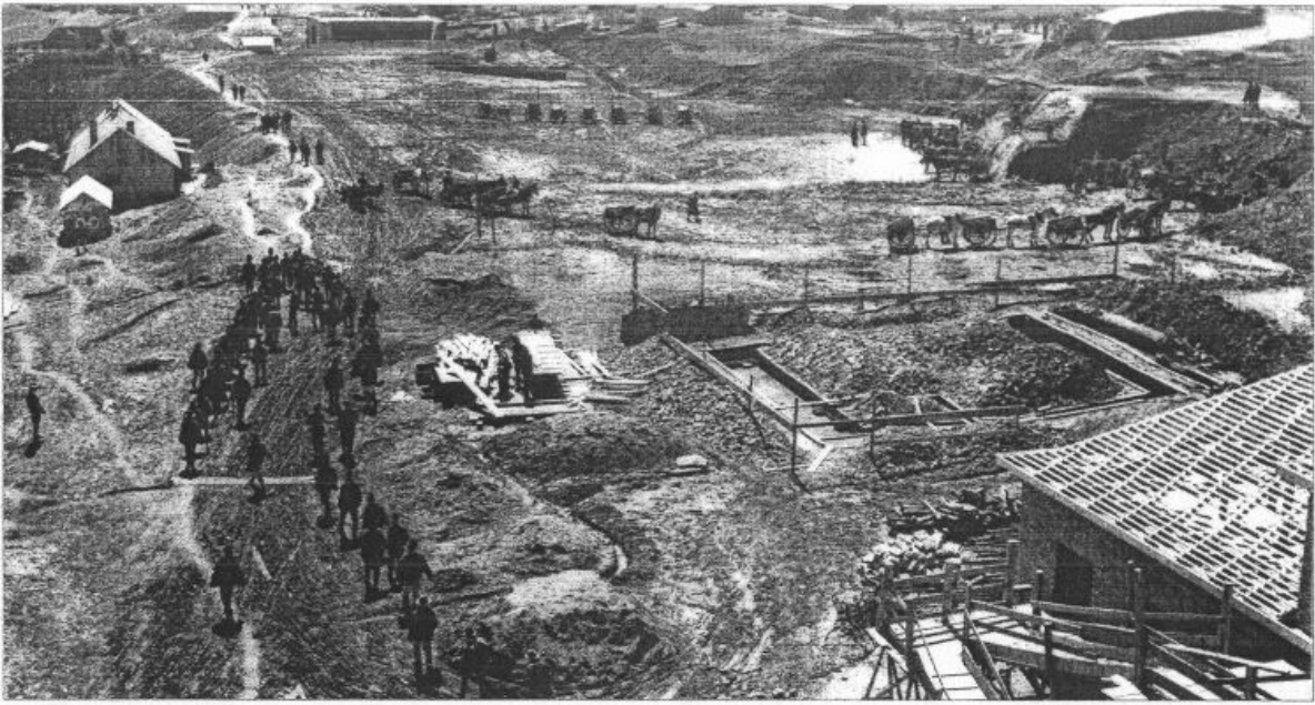
51. ábra. Monorfalva állomás építése
