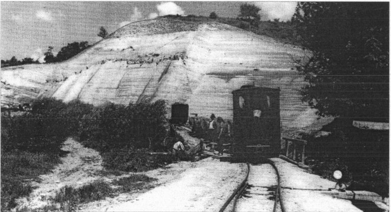
15. ábra. Földszállítás kisvasúttal a dédai anyagyerőhelyről
