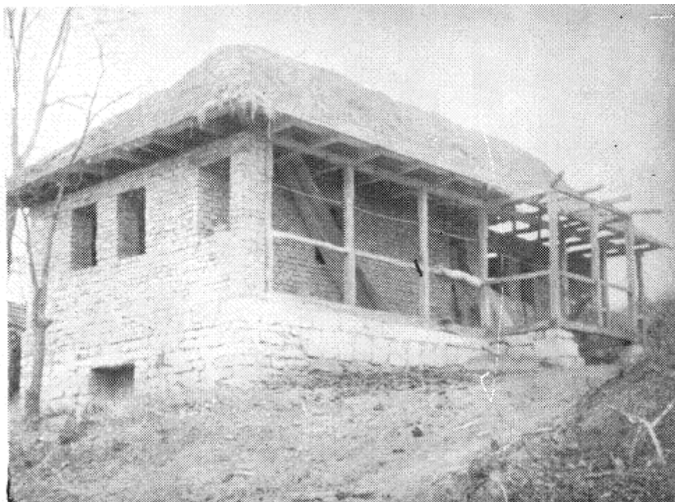
8. Épülő vályogfalú ház, alol pincével, Vervölgy.
