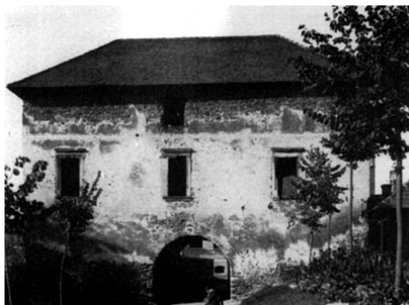
251. Szilágysomlyó, a vár kapubástya, belső homlokzat. 1592
