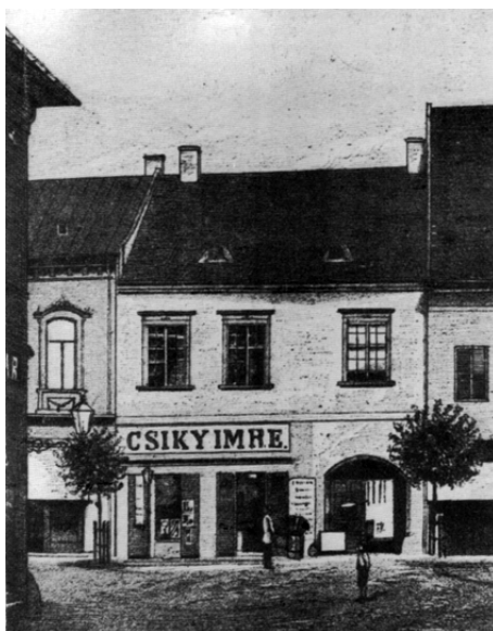
121. A Wolphard-Kakas ház homlokzata. 1893. Fő tér 32 (31). sz.
