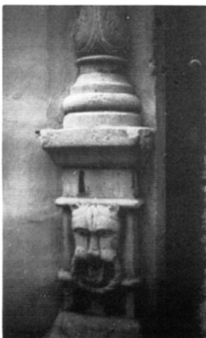
113–114. Részletek a Híd utcai ház ajtajából. Befalazva az egykori Pákei villában
