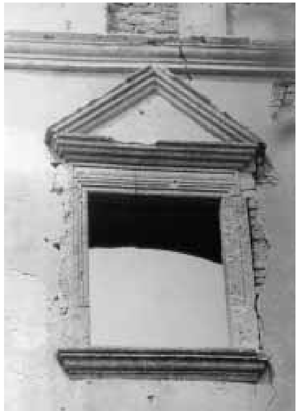
218. Aranyosmeggyes. Ablakkeret a torony legfelső szintjén
