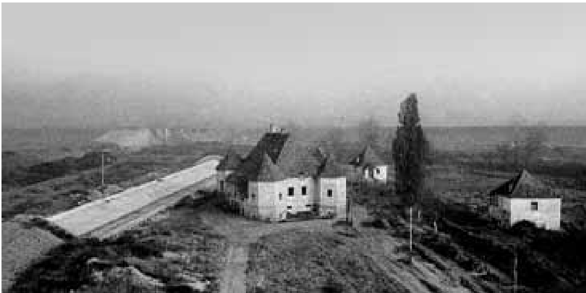
117. Kisbún. A kastély a víztározó megépítése után. 1980–1981.
