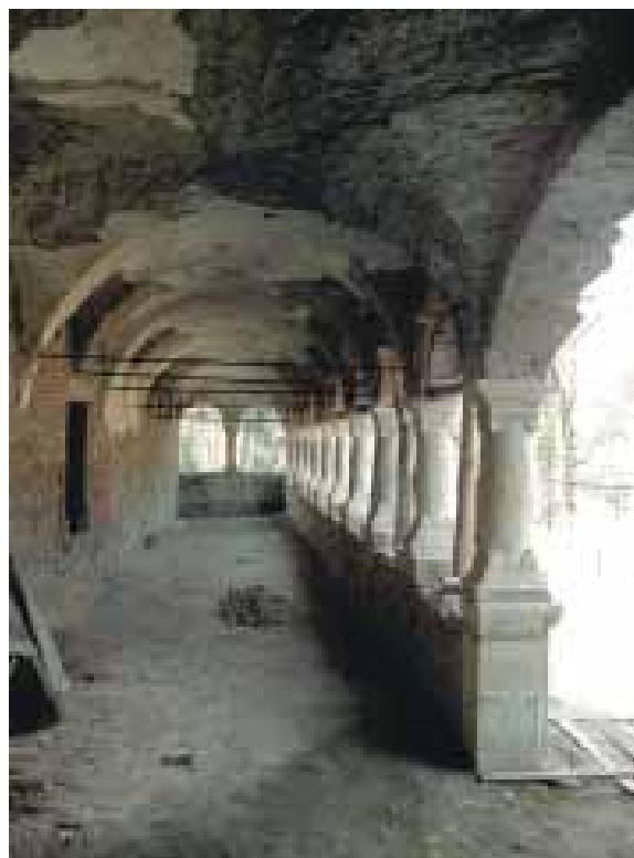
246. Keresd. A loggia
