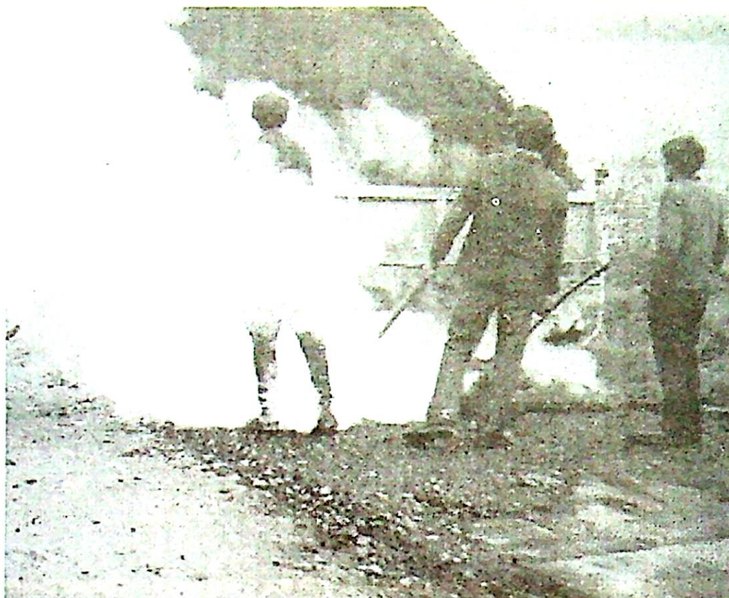
A paniti bekötő út aszfaltozásának megkezdése
